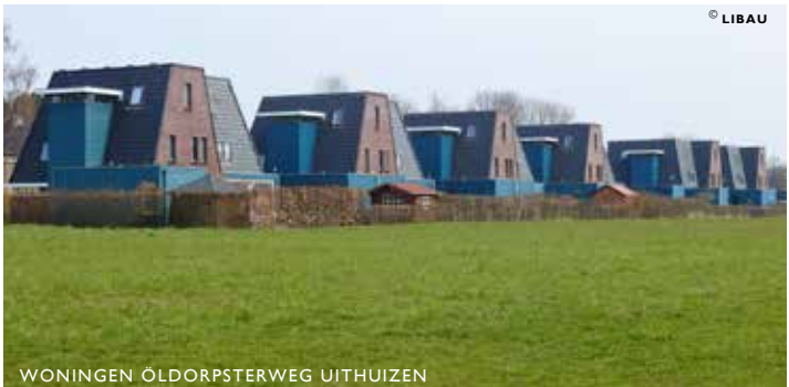
WONINGEN ÔLDORPSTERWEG UITHUIZEN
