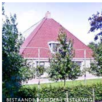
BESTAANDE BOERDERIJ EESTERWEG
