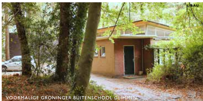
VOORMALIGE GRONINGER BUITENSCHOOL GLIMMEN
