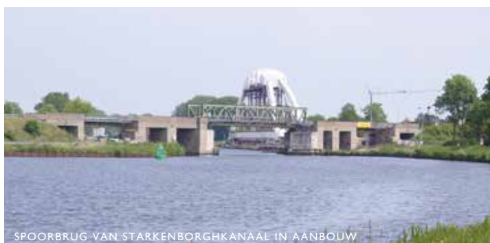
SPOORBRUG VAN STARKENBORGHKANAAL IN AANBOUW
